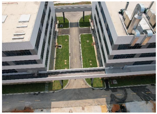
雨水管网、雨水口、检查井
